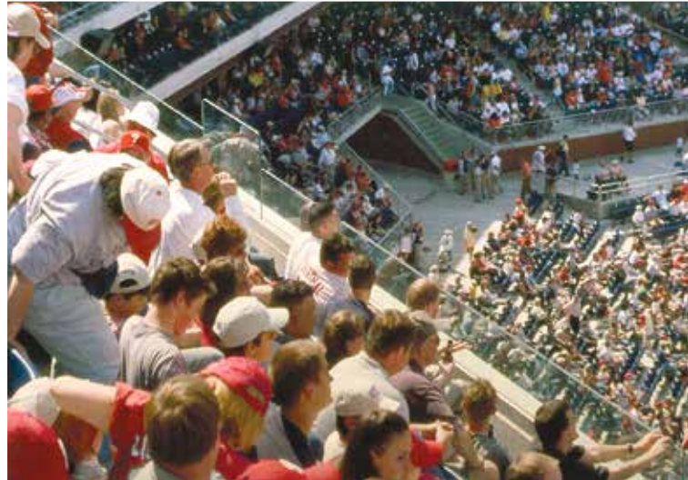
美国宾夕法尼亚 Phillis Stadium 球场采用 SentryGlas® 制成的玻璃栏杆，实现单边固定安装和边部开放效果。
