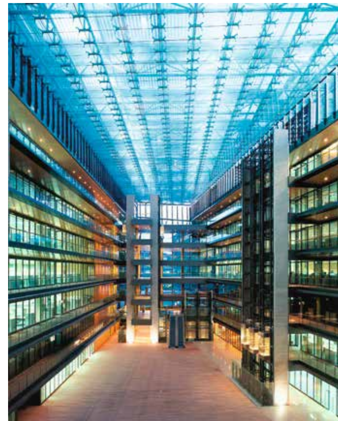
西班牙能源巨头Endesa, 在其马德里总部大楼安装了采用 SentryGlas® 的玻璃天棚, 不但明亮透光, 而且通风节能。
